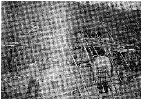
山の村でのワーク新教会堂建設(4)
