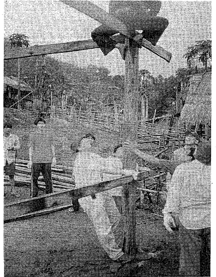
山の村でのワーク新教会堂建設(3)
