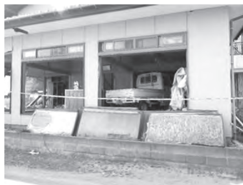
図5) 津波被害後3年近くそのままの民家 (福島県富岡町)
