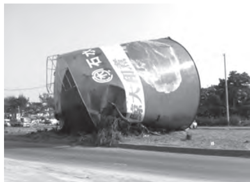
図 3) 津波被害を受けた水産加工会社のタンク (宮城県石巻市)
